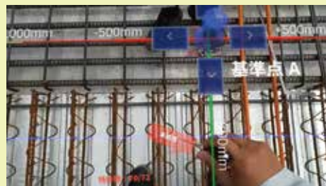
GyroEyeインサート(設備インサート墨出し支援MRシステム)
